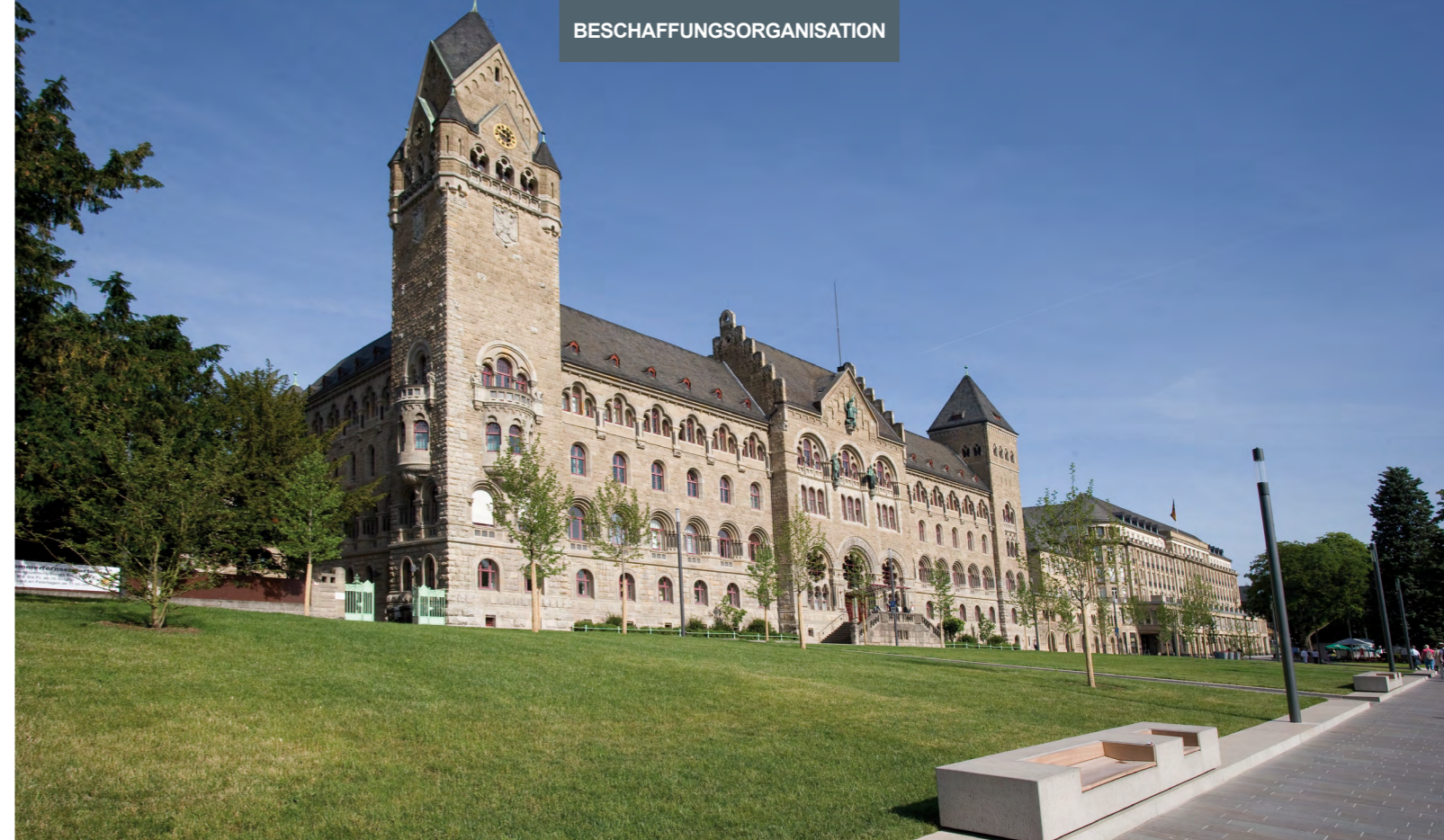
▲ Bundesamt für Ausrüstung, Informationstechnik und Nutzung der Bundeswehr, Bundesbehördenhaus, Konrad-Adenauer-Ufer, 56068 Koblenz, Quelle: Bundeswehr/Daniela Thiermann
