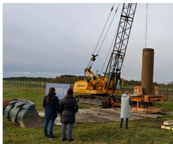
Flugplatz Manching, Bau Sanierungsbrunnen
